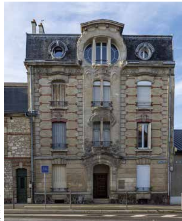
Rue Emile ZOLA, rare exemple de préservation d'une architecture "Art Nouveau", reconstruite en conservant les éléments outrepassés caractéristiques
