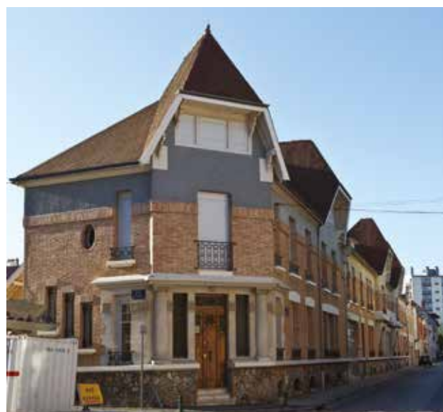
PC 3710 - 49/55, rue des Moissons 1923
