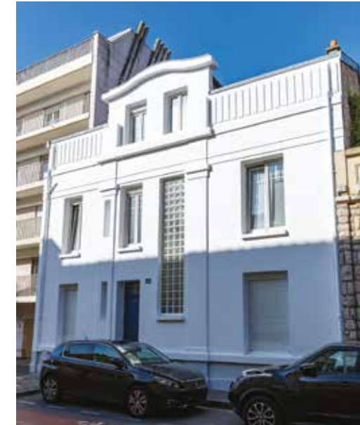
PC 4940 – 58, rue des Moissons 1924
