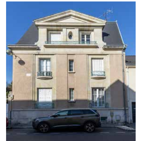
PC 4120 - 72, rue des Moissons 1924
