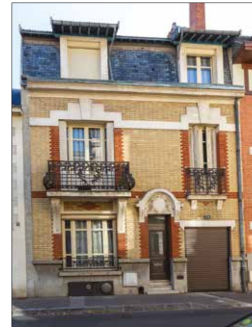
PC 2852 - 71, rue des Moissons 1923
