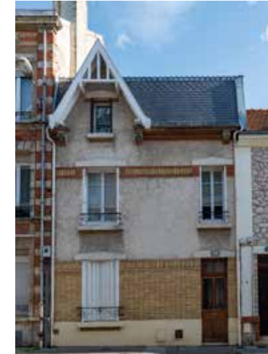
PC 3527 - 30, rue des Murs 1923
