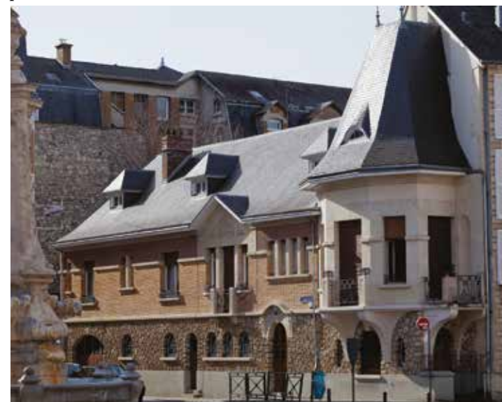
PC 395 - 2, rue Saint-Pierre-les-Dames 1922
