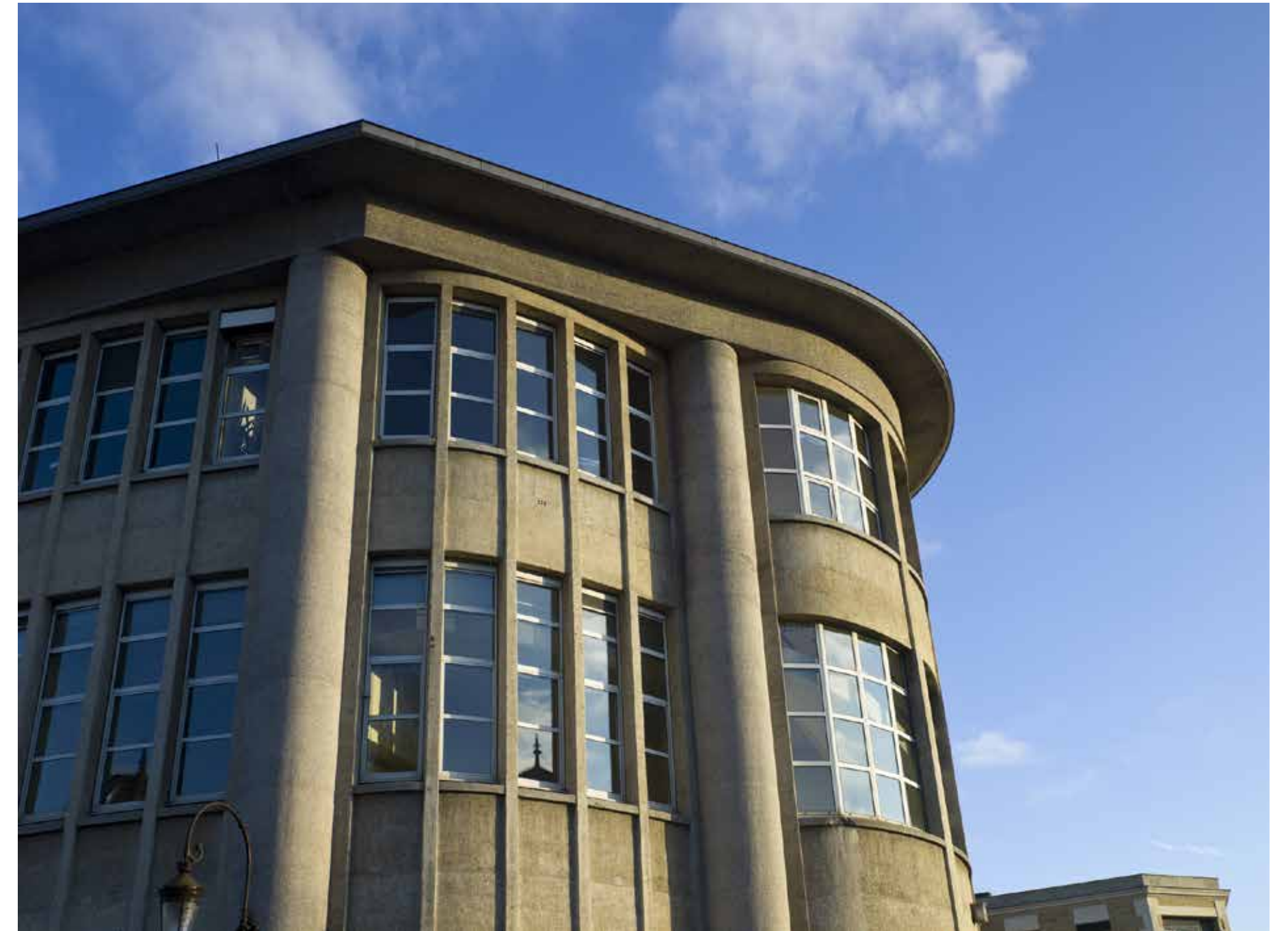
L'Hôtel des Postes, réalisation magistrale de l'architecte François Le Cœur
