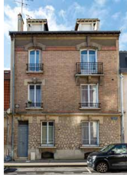
PC 3610 - 15, rue des Murs 1923
